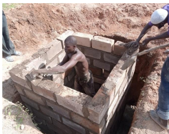
Photo 2- Réalisation d'une latrine vip simple fosse (© SNV, 2021)
