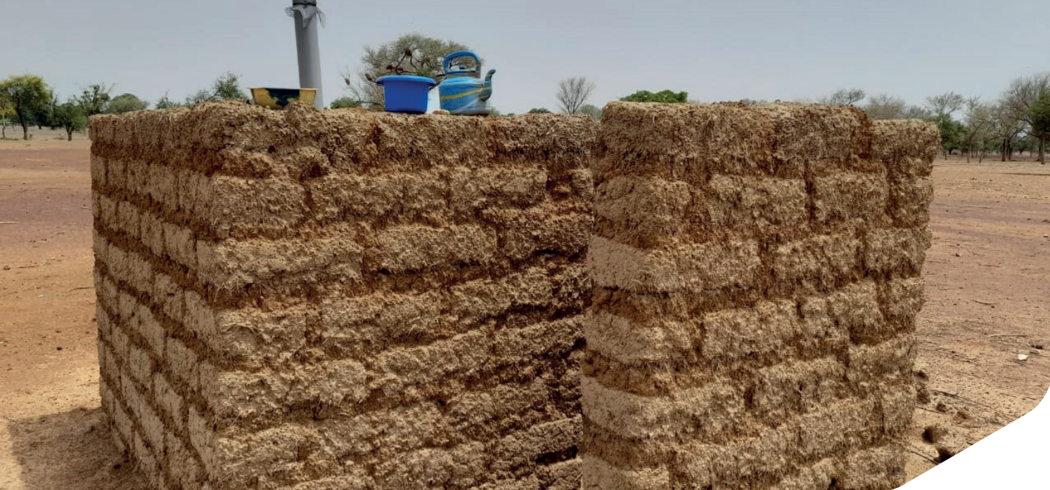
Latrine réalisée dans le village de ZINA, commune de KONA, 2022
