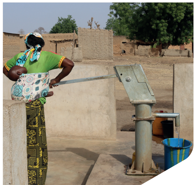
Une pompe à motricité humaine réalisée dans le village de Sirakorosso
